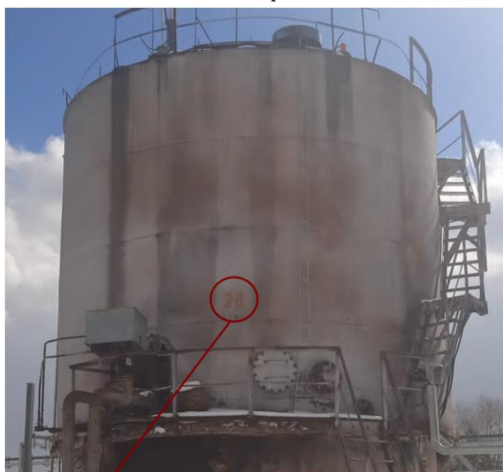
Рисунок 5 – Общий вид резервуара РВС-200 №27 с указанием места нанесения заводского номера
