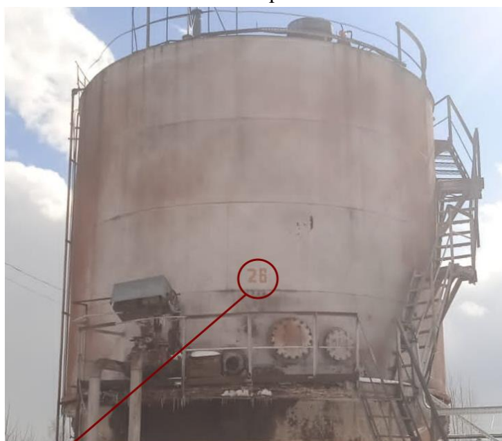
Рисунок 3 – Общий вид резервуара РВС-200 №25 с указанием места нанесения заводского номера
