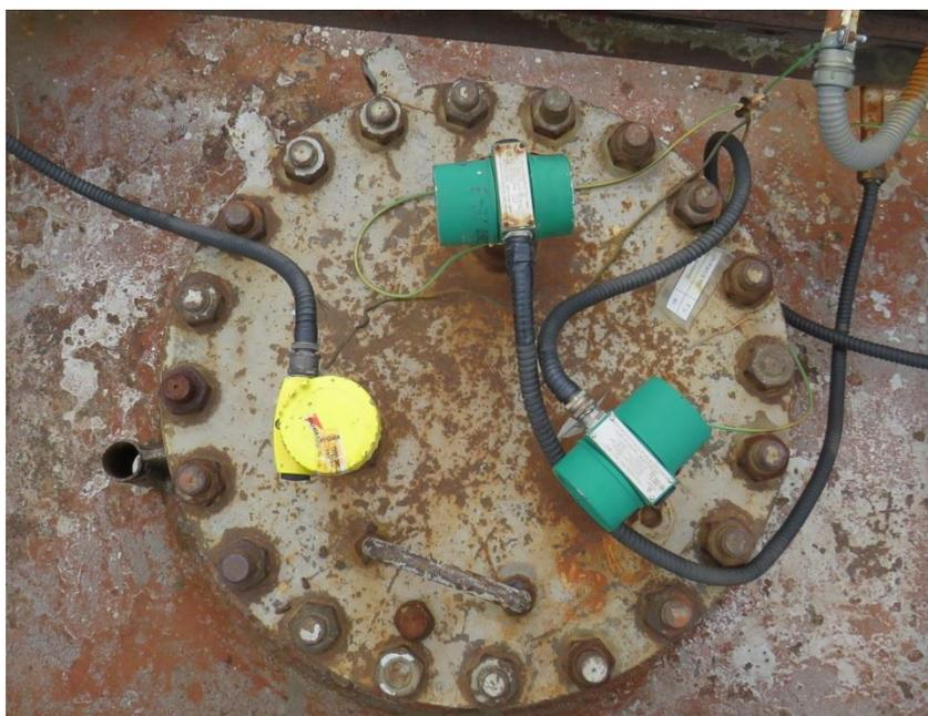
Рисунок 3 – Фото горловины и замерного люка резервуаров РГС-200
