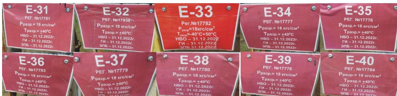
Рисунок 2 – Место нанесения заводских номеров резервуаров РГС-200
