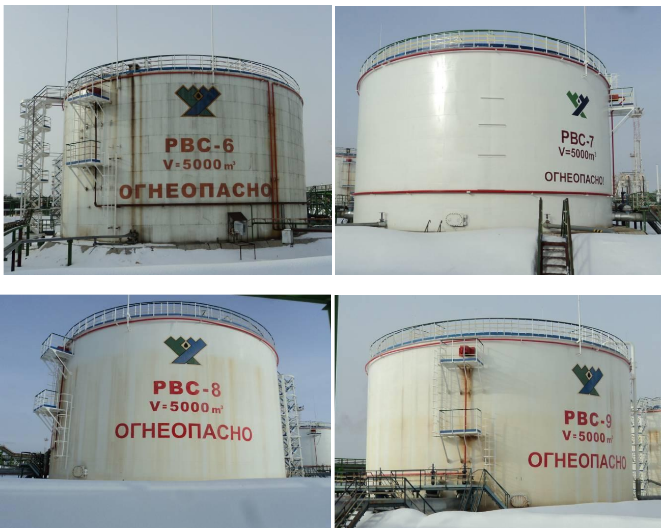
Рисунок 1 - Общий вид РВС-5000 зав. №№ 6, 7, 8, 9
