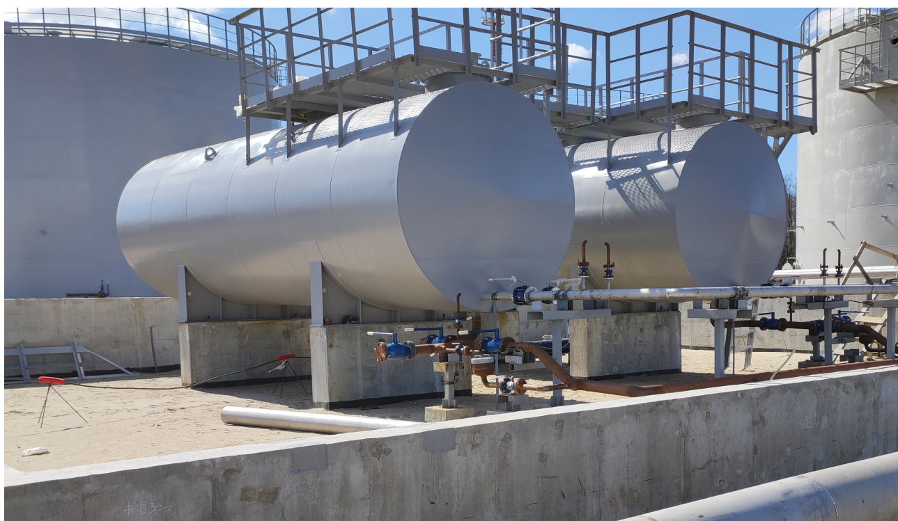
Рисунок 2 – Общий вид резервуаров РГСН-50 Пломбирование резервуаров РГСН-50 не предусмотрено.
