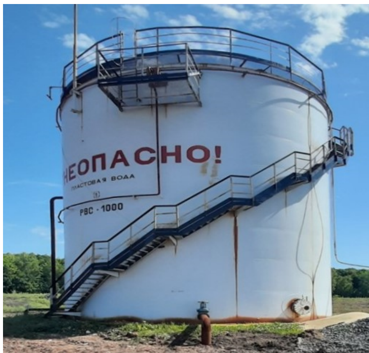
Рисунок 1 – Общий вид резервуара РВС-1000
