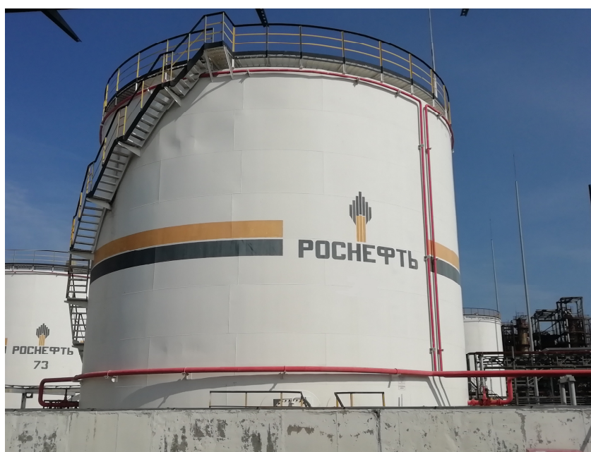
Рисунок 1 – Общий вид резервуаров РВС-2000
