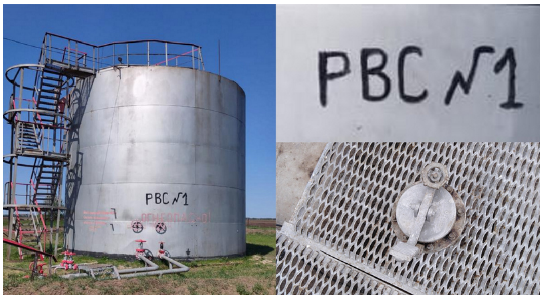
Рисунок 1 – Общий вид резервуара стального вертикального цилиндрического РВС-400
