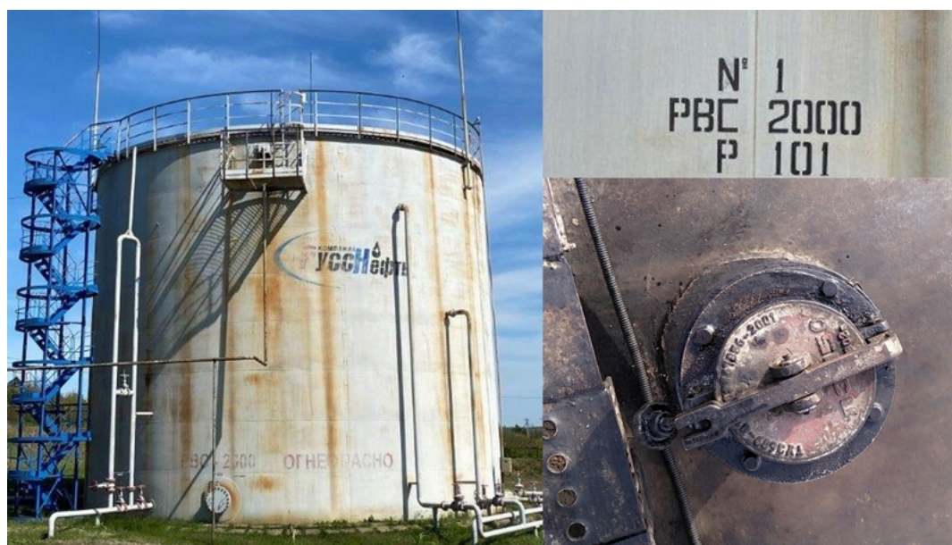
Рисунок 1 – Общий вид резервуара стального вертикального цилиндрического PBC-2000, горловины и заводского номера
