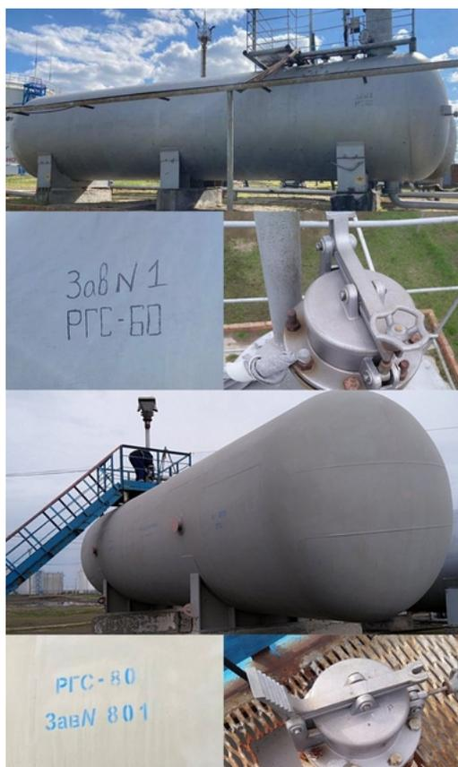
Рисунок 1 – Общий вид резервуаров стальных горизонтальных цилиндрических РГС-60, РГС-80, их горловин и заводских номеров
