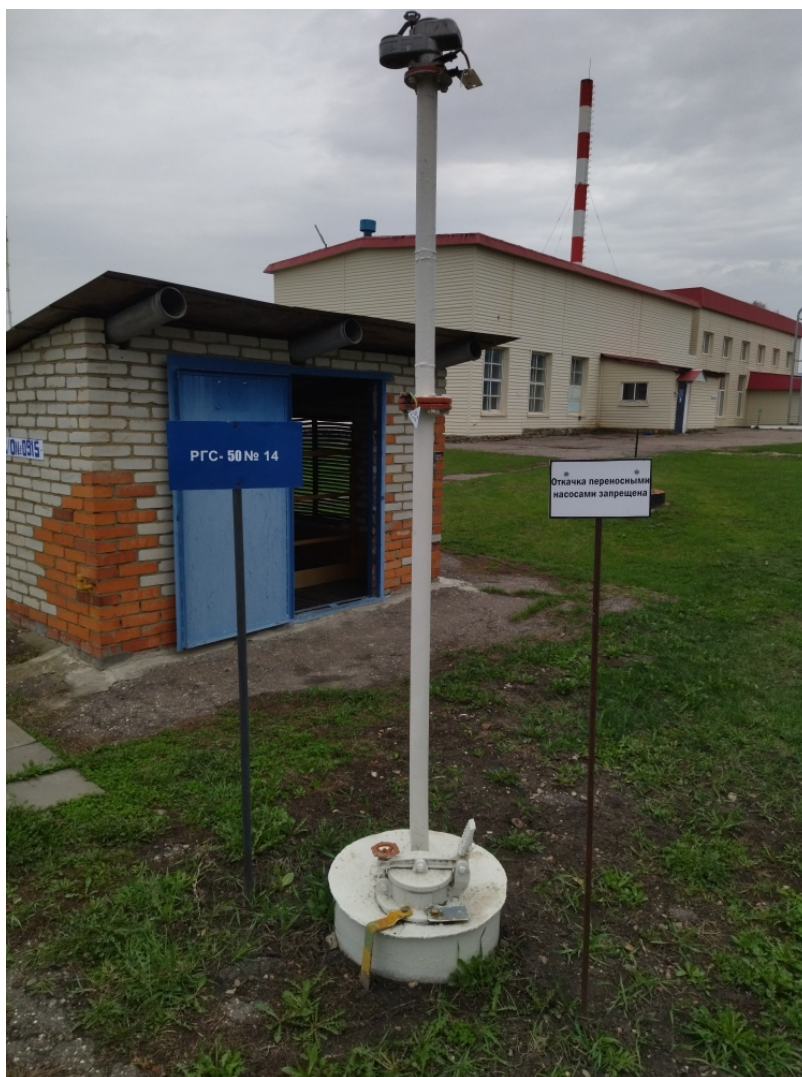
Рисунок 1 – Место нанесения заводского номера
