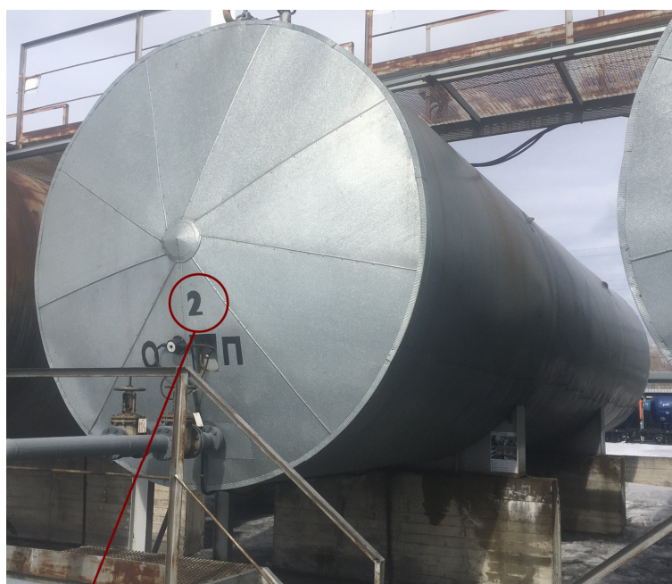
Рисунок 1 – Общий вид резервуара РГС-100 №1 с указанием места нанесения заводского номера
