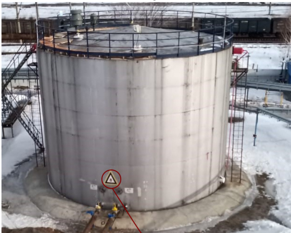
Рисунок 2 – Общий вид резервуара РВС-1000 №7 с указанием места нанесения заводского номера
