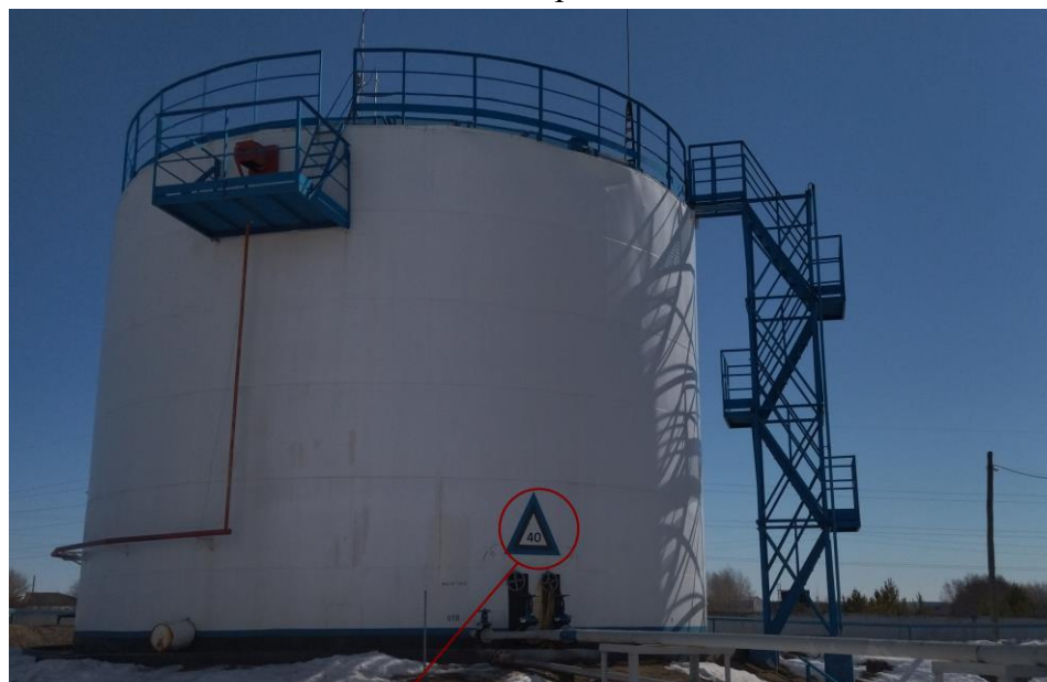
Рисунок 1 – Общий вид резервуара РВС-1000 №37 с указанием места нанесения заводского номера
