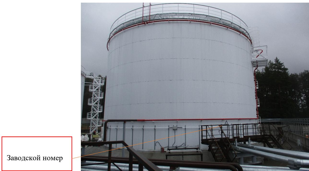
Рисунок 4 - Общий вид резервуара вертикального стального цилиндрического РВС-3000 заводской номер 33 с указанием места нанесения заводского номера
