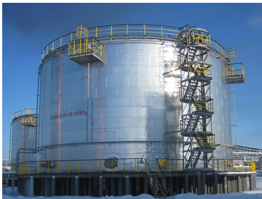
Рисунок 1 – Общий вид резервуара РВС-5000
