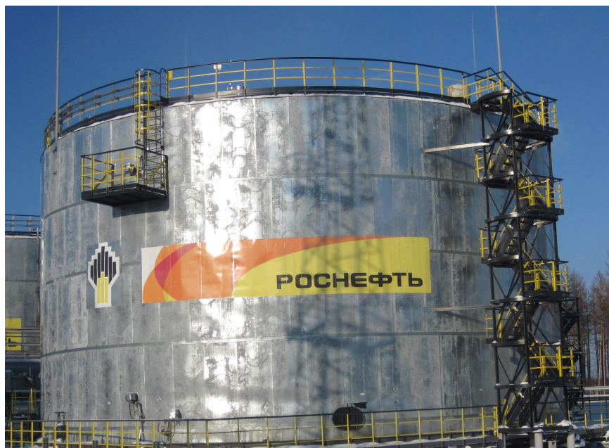
Рисунок 1 – Общий вид резервуара РВС-5000
