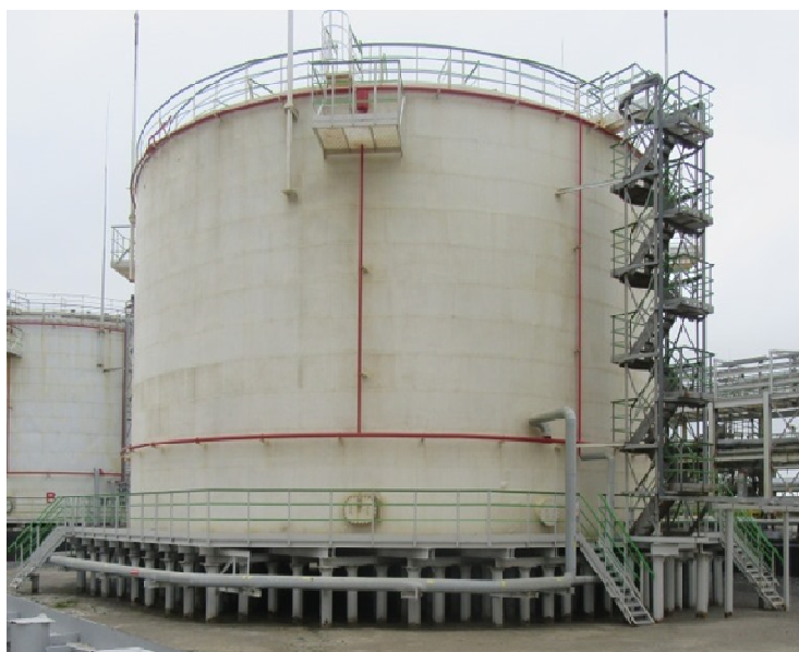
Рисунок 1 – Общий вид резервуара РВС-5000
