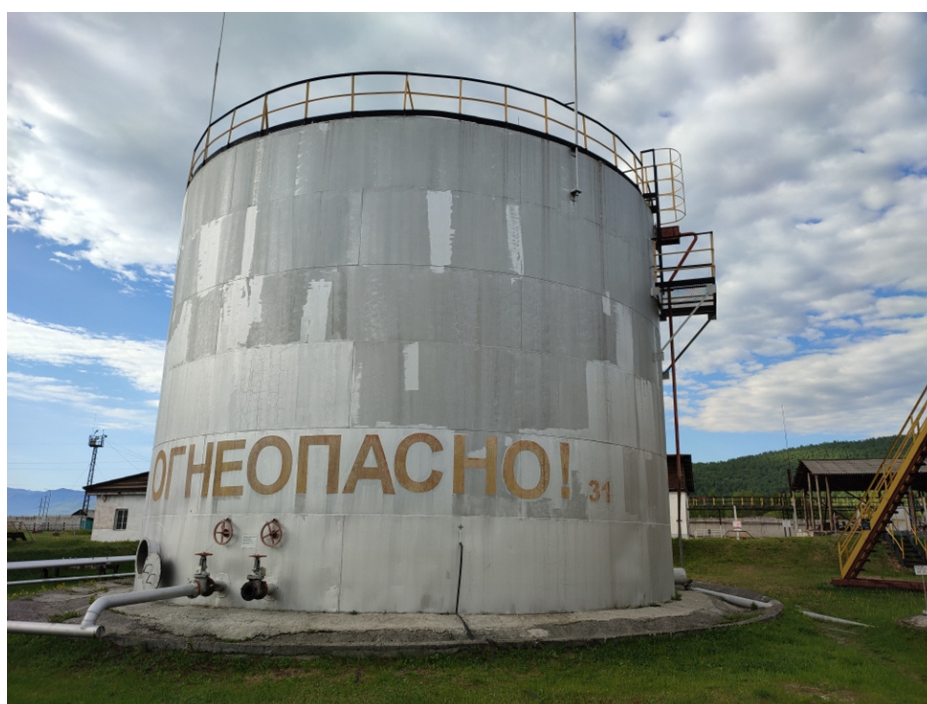
Рисунок 1 – Общий вид резервуара РВС-1000
