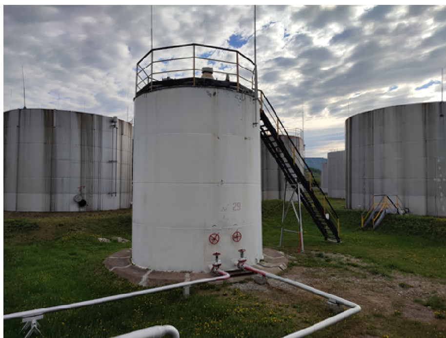
Рисунок 1 – Общий вид резервуара РВС-100
