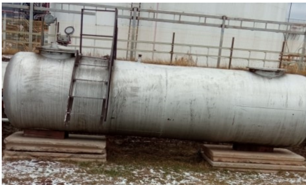
Рисунок 1 – Общий вид резервуара
