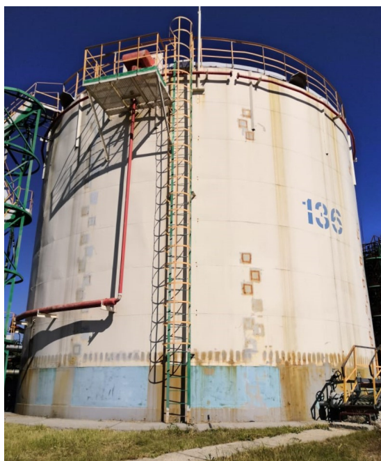
Рисунок 1 – Общий вид резервуаров РВСП-2000
