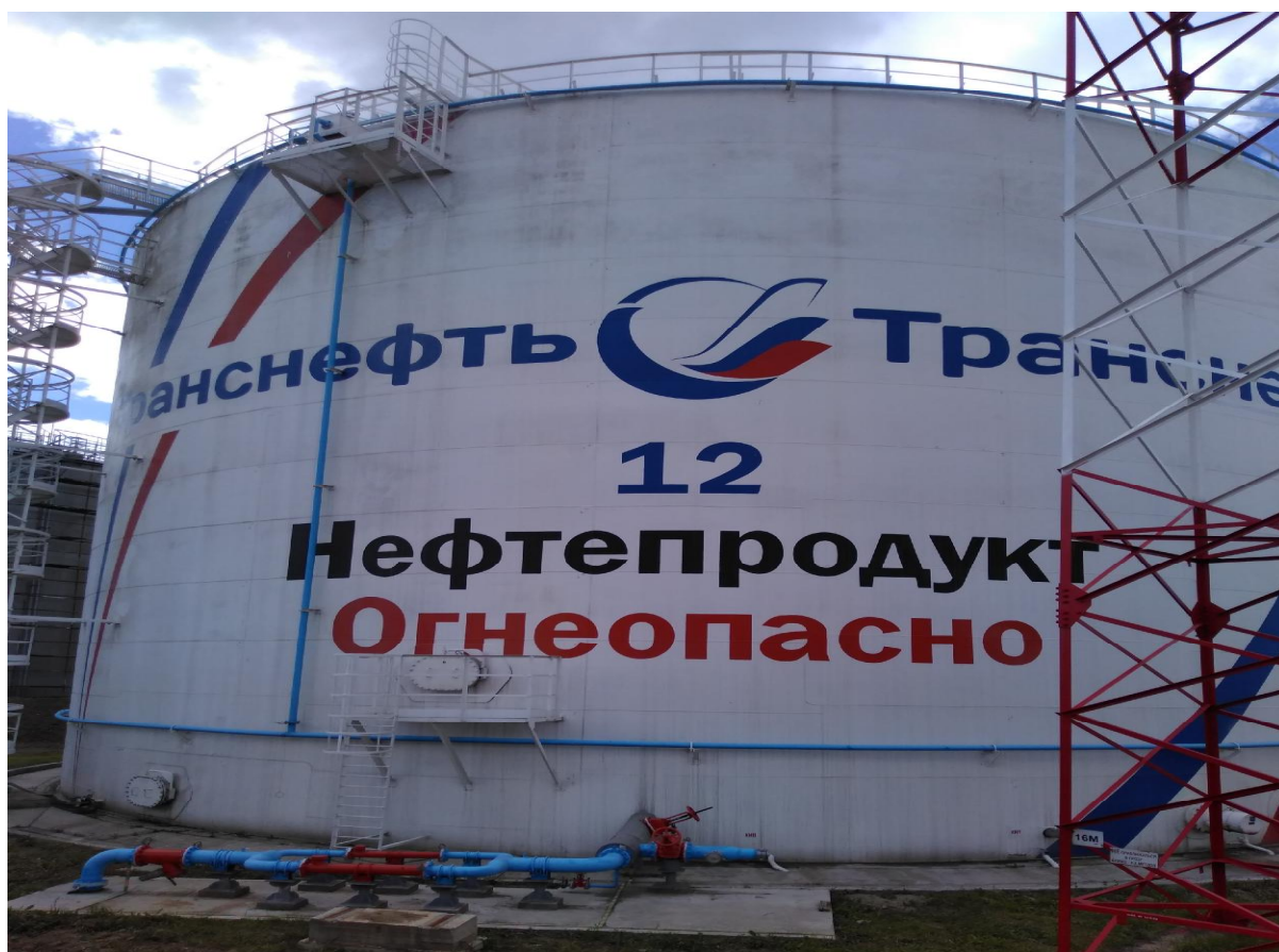
Рисунок 3 - Общий вид резервуаров вертикальных стальных цилиндрических РВСП-10000
