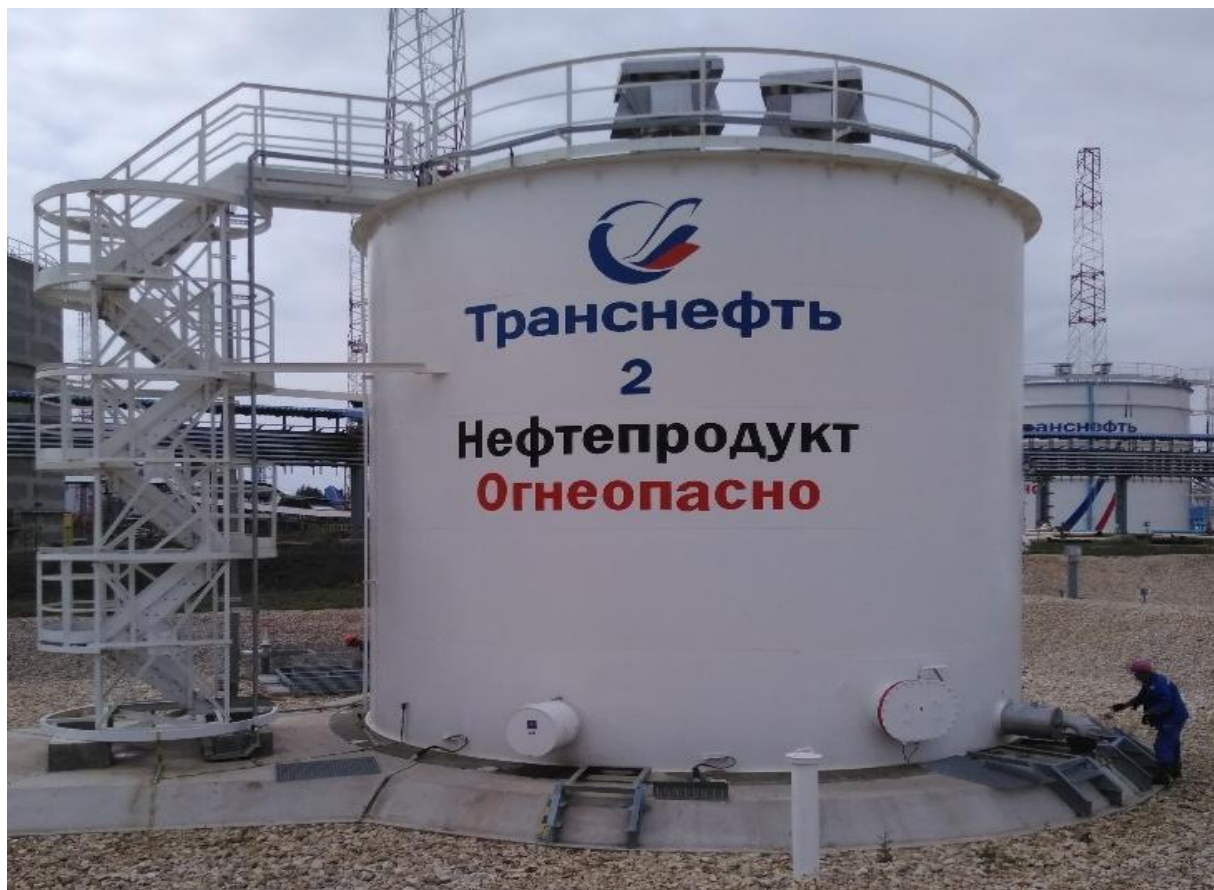
Рисунок 1 - Общий вид резервуаров вертикальных стальных цилиндрических РВС-400
