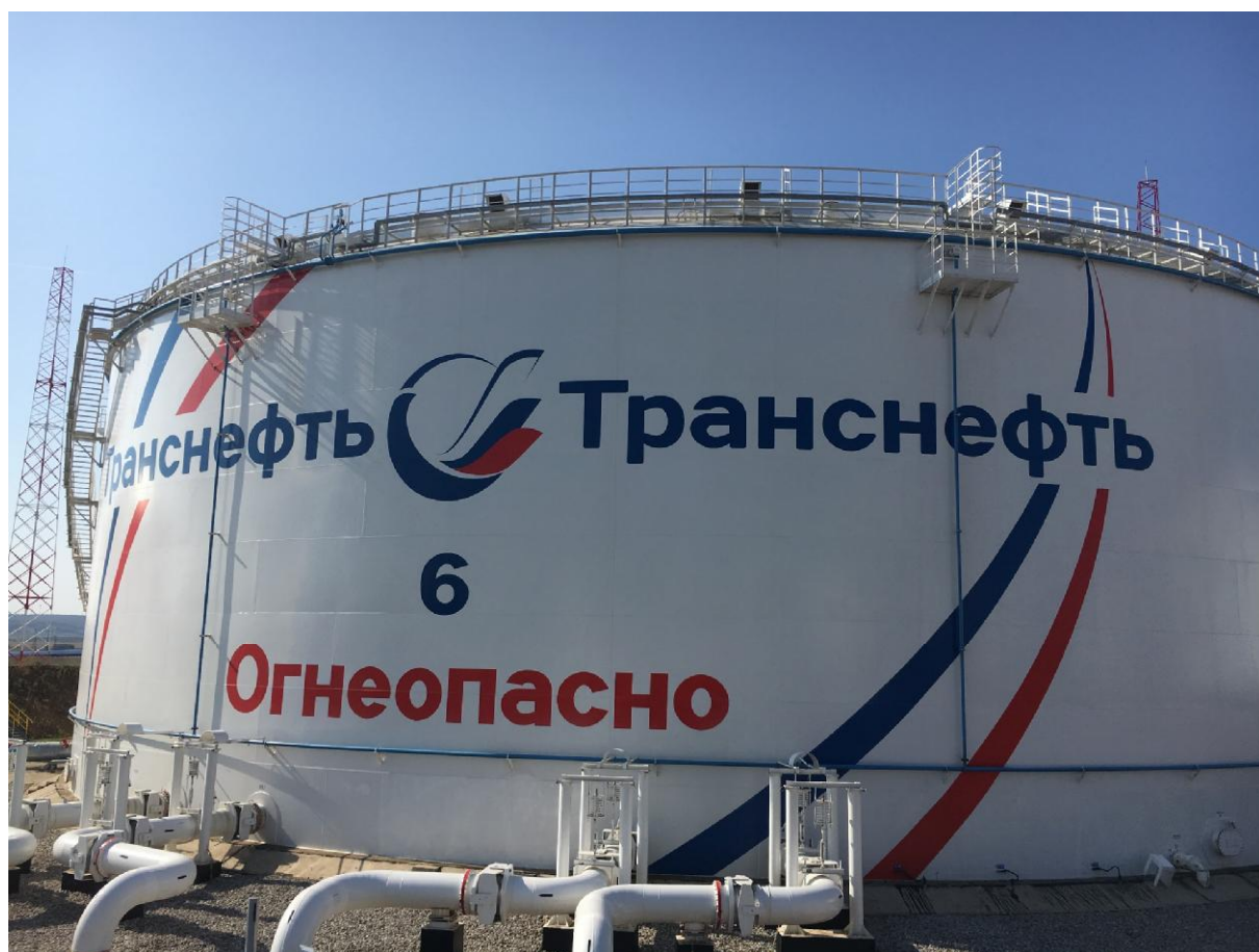
Рисунок 4 - Общий вид резервуаров вертикальных стальных цилиндрических РВСП-50000
