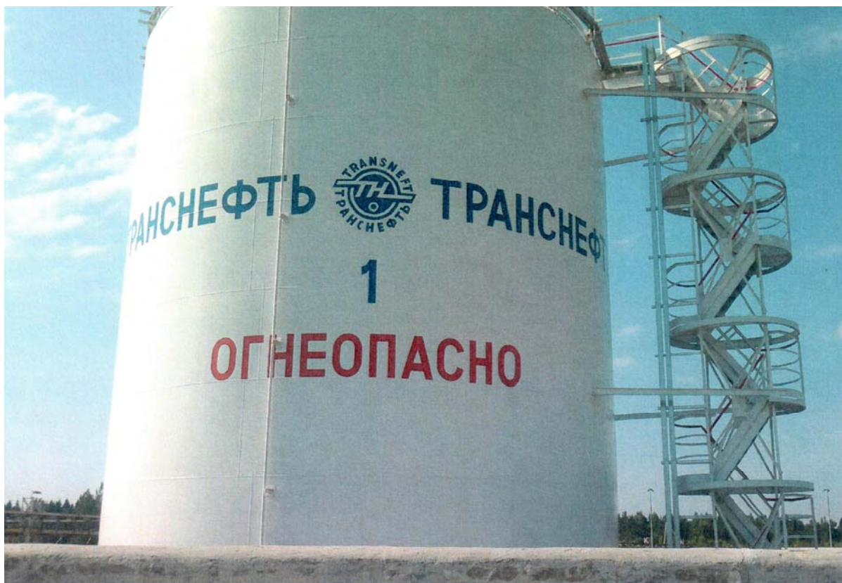
Рисунок 1 - Общий вид резервуара вертикального стального цилиндрического РВС-1000
