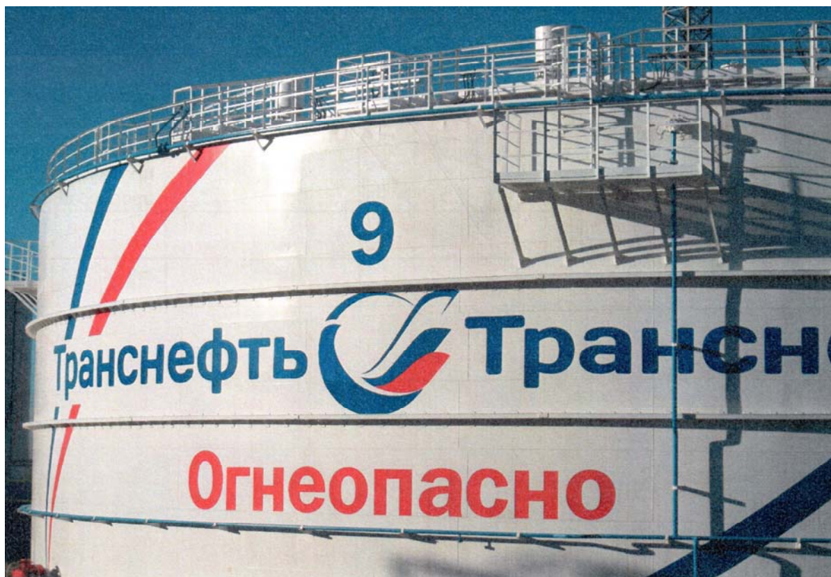
Рисунок 4 - Общий вид резервуара вертикального стального цилиндрического РВСП-20000
