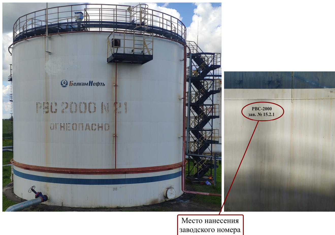
Рисунок 2 – Общий вид резервуара РВС-2000 №15.2.1 с указанием места нанесения заводского номера
