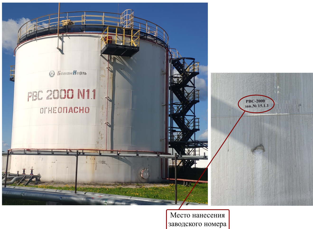
Рисунок 1 – Общий вид резервуара РВС-2000 №15.1.1 с указанием места нанесения заводского номера
