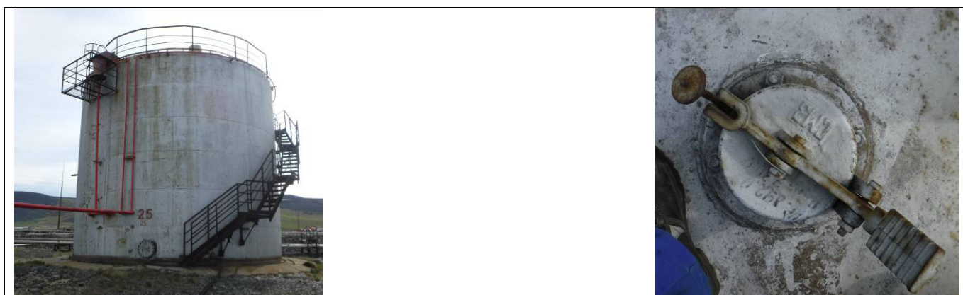
Рисунок 8 – Общий вид резервуара РВС-700 (№25) с замерным люком
