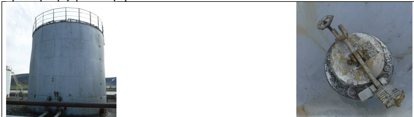
Рисунок 1 – Общий вид резервуаров РВС-200 (№3) с замерным люком
