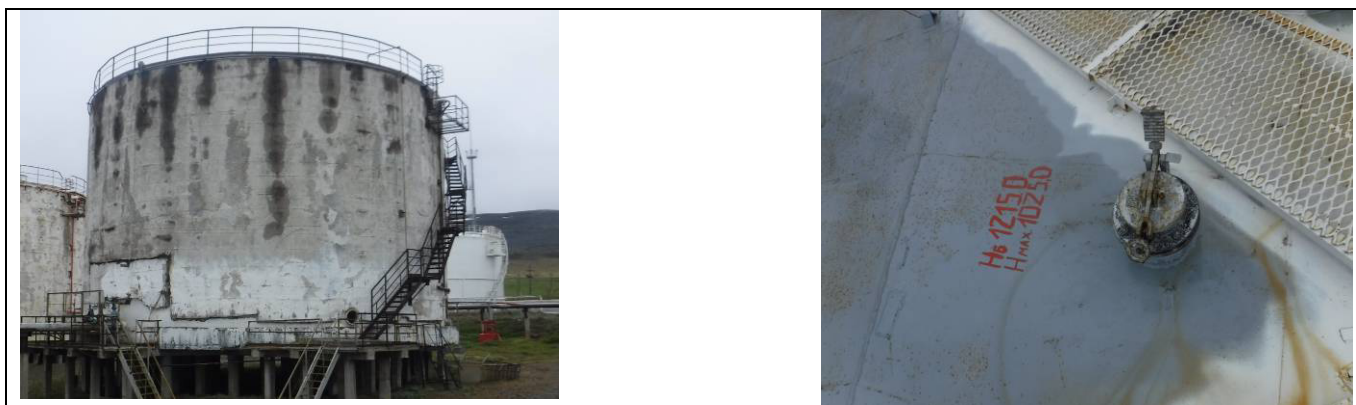
Рисунок 15 – Общий вид резервуара РВС-3000 (№51) с замерным люком
