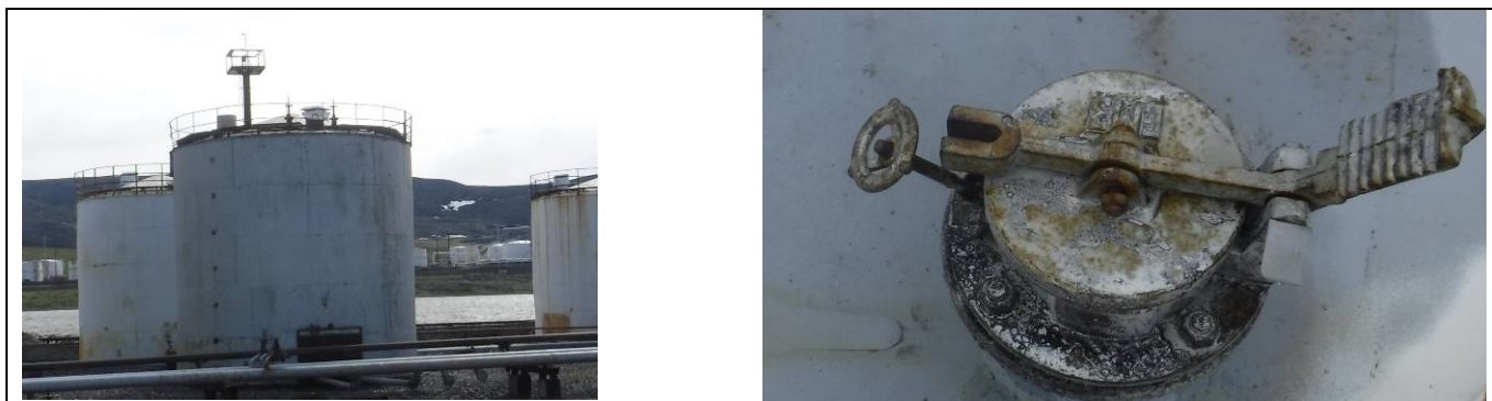
Рисунок 2 – Общий вид резервуара РВС-200 (№4) с замерным люком
