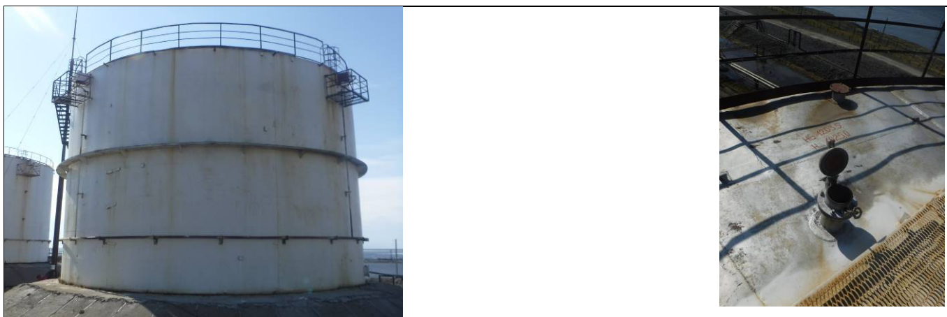
Рисунок 14 – Общий вид резервуара РВС-3000 (№42) с замерным люком
