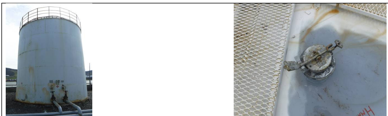
Рисунок 4 – Общий вид резервуара РВС-200 (№7) с замерным люком
