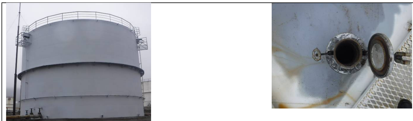
Рисунок 17 – Общий вид резервуара РВС-3000 (№56) с замерным люком
