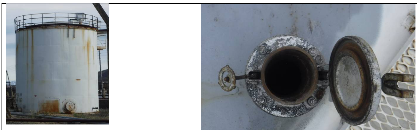
Рисунок 5 – Общий вид резервуара РВС-200 (№8) с замерным люком
