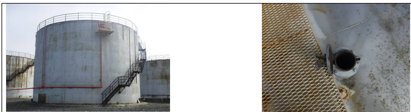
Рисунок 13 – Общий вид резервуара РВС-3000 (№37) с замерным люком
