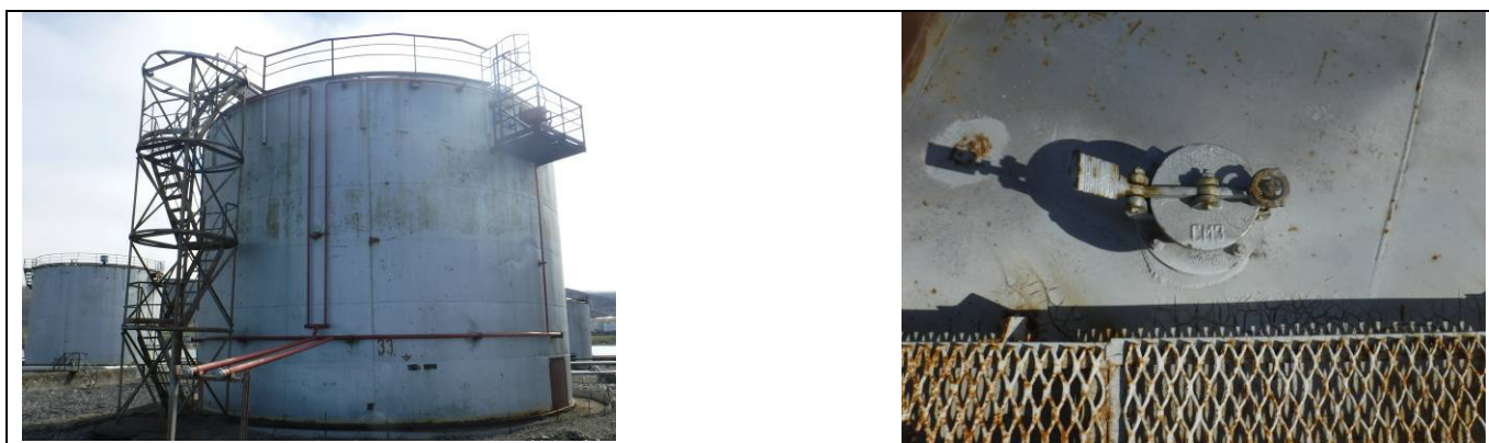
Рисунок 12 – Общий вид резервуара РВС-1000 (№33) с замерным люком
