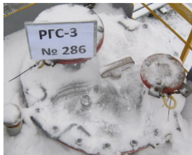
Рисунок 3 – Фотография горловины и заводского номера 2 секции резервуара стального горизонтального цилиндрического РГС-20 (17+3), заводской номер 286
