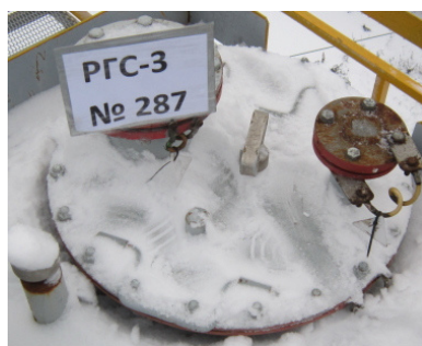
Рисунок 5 – Фотография горловины и заводского номера 2 секции резервуара стального горизонтального цилиндрического РГС-20 (17+3), заводской номер 287
