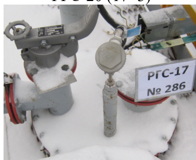
Рисунок 2 – Фотография горловины и заводского номера 1 секции резервуара стального горизонтального цилиндрического РГС-20 (17+3), заводской номер 286
