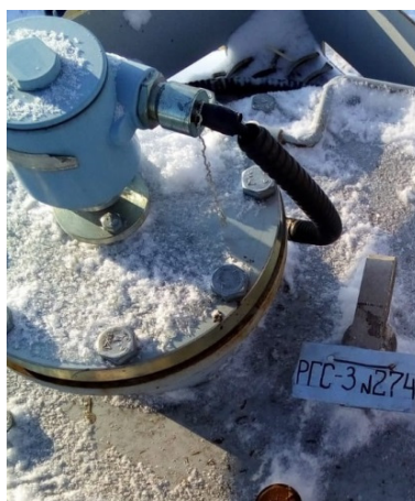
Рисунок 3 – Фотография горловины и заводского номера 2 секции резервуара стального горизонтального цилиндрического РГС-20 (17+3), заводской номер 274
