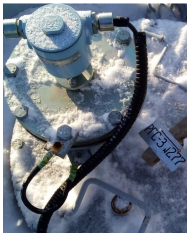
Рисунок 5 – Фотография горловины и заводского номера 2 секции резервуара стального горизонтального цилиндрического РГС-20 (17+3), заводской номер 277
