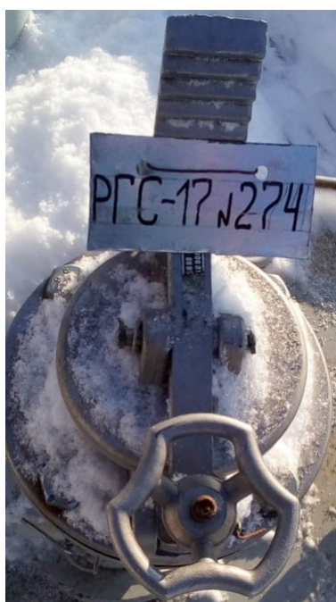
Рисунок 2 – Фотография горловины и заводского номера 1 секции резервуара стального горизонтального цилиндрического РГС-20 (17+3), заводской номер 274
