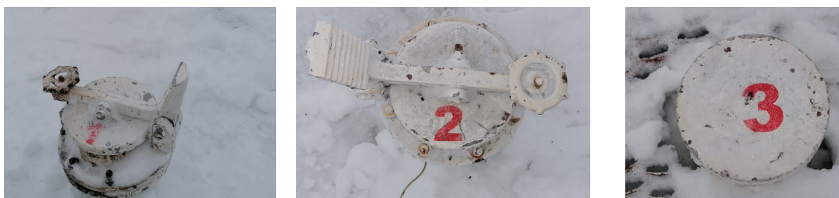
Рисунок 2 – Замерные люки резервуара стального вертикального цилиндрического PBC-3000
