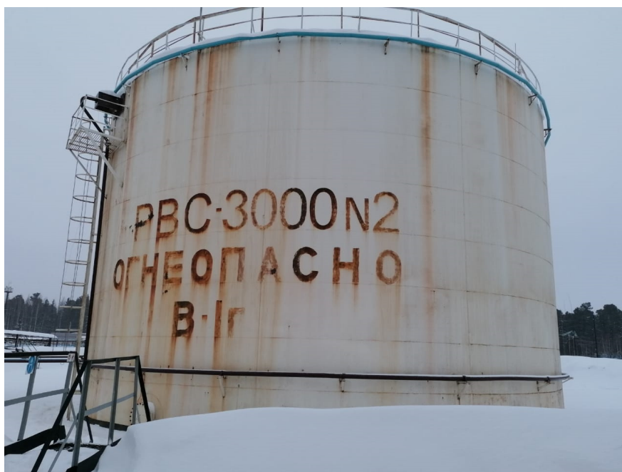
Рисунок 1 – Внешний вид резервуара стального вертикального цилиндрического PBC-3000
