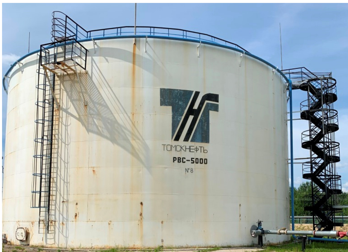
Рисунок 1 – Общий вид резервуара и заводской номер Пломбирование резервуара не предусмотрено.
