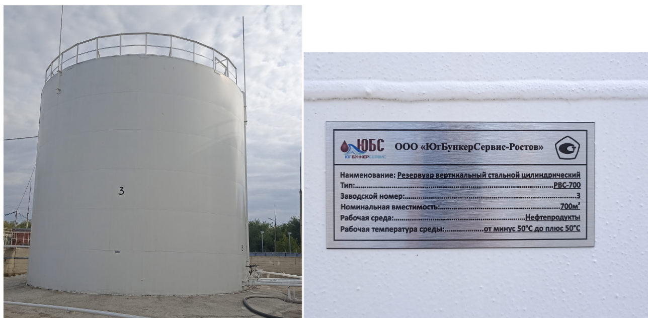
Рисунок 1 – Общий вид резервуара РВС-700 с указанием места нанесения заводского номера
