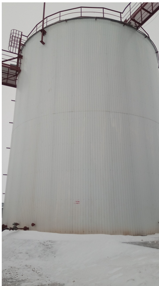
Рисунок 3 – Общий вид резервуара РВС-1500 с заводским номером 047/21
