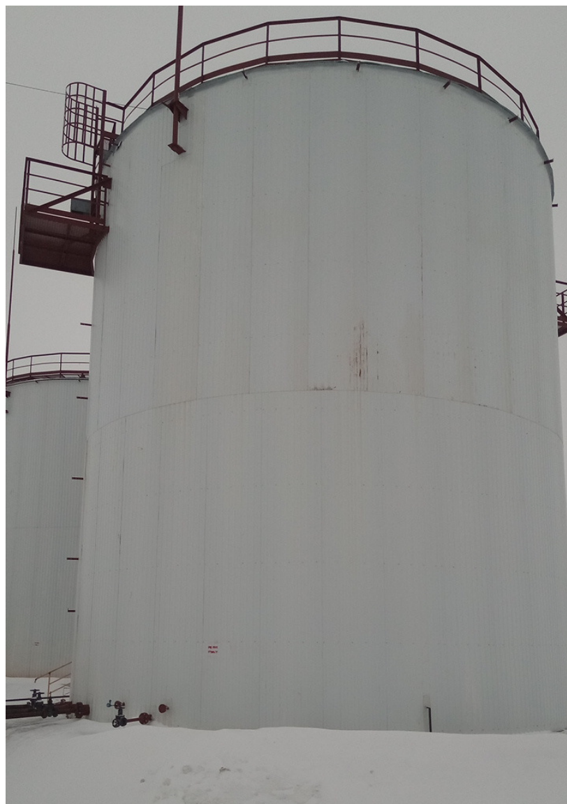
Рисунок 2 – Общий вид резервуара РВС-1500 с заводским номером 046/21
