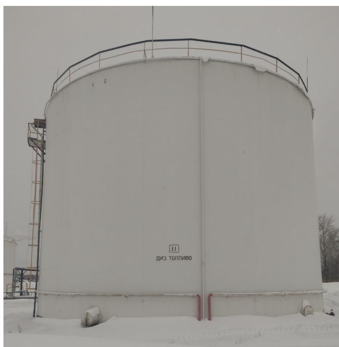
Рисунок 1 – Общий вид резервуаров РВС-5000
