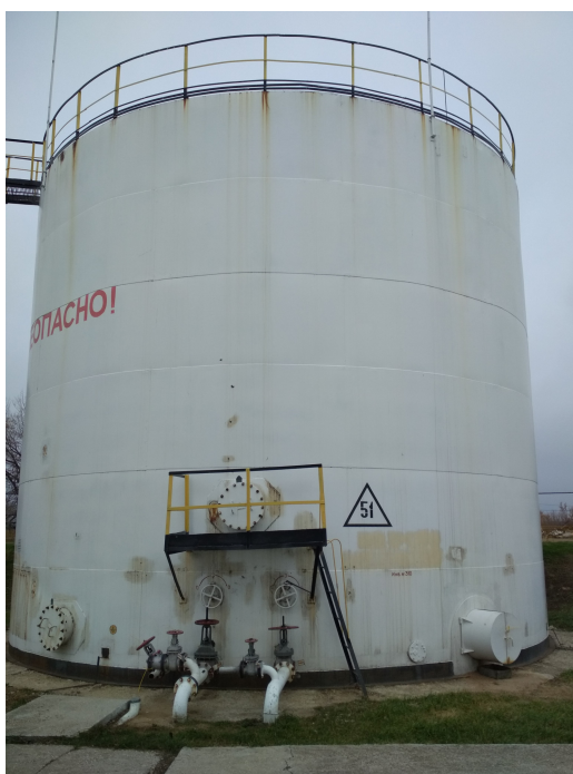
Рисунок 1 – Общий вид резервуаров РВС-700
