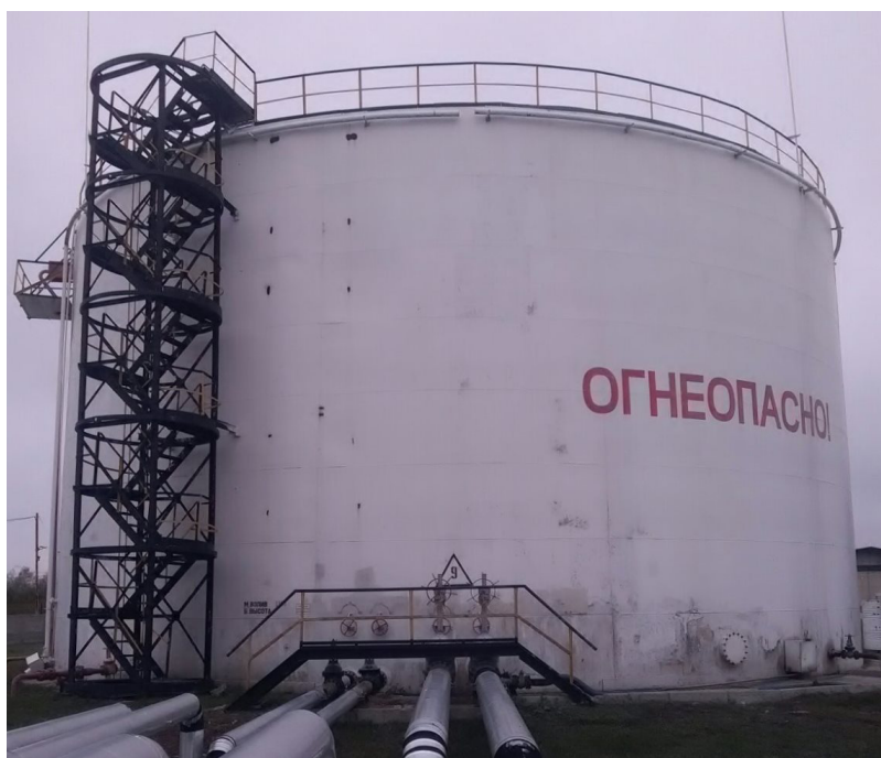
Рисунок 1 – Общий вид резервуаров РВС-5000
