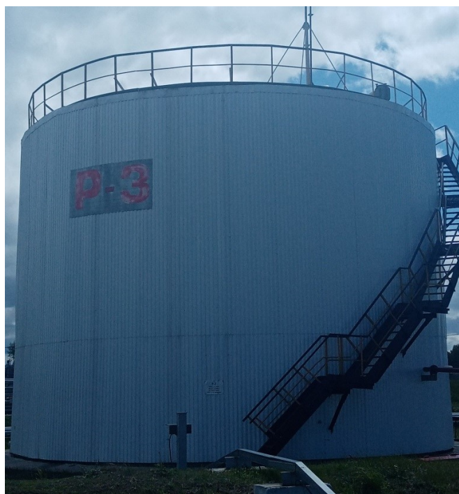
Рисунок 1 – Общий вид резервуаров РВС-1000
