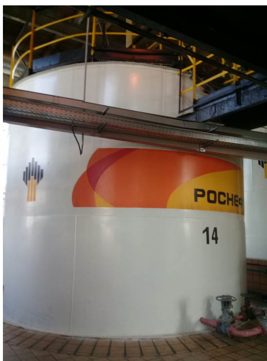
Рисунок 1 – Общий вид резервуара РВС-100
