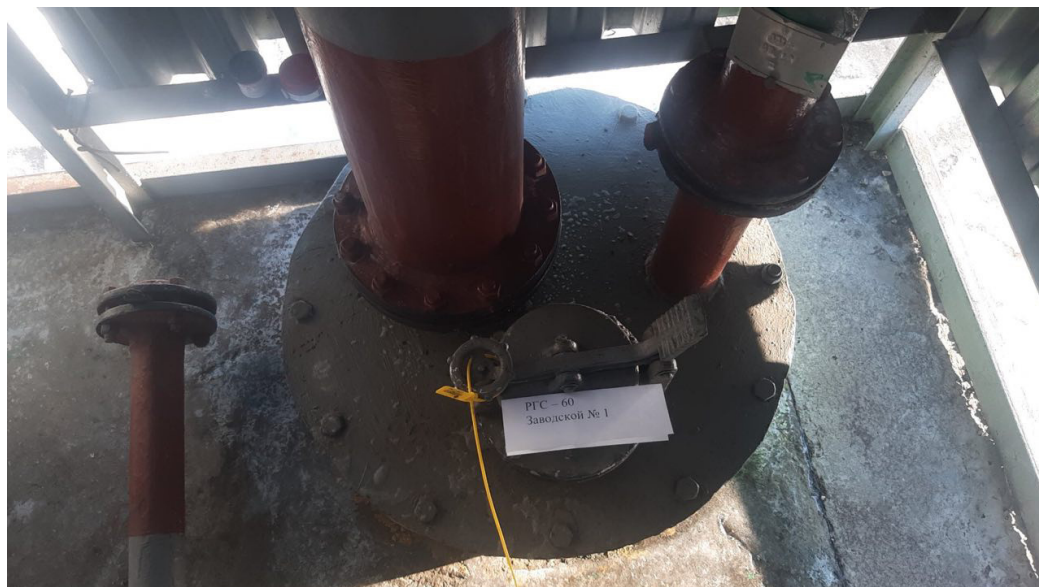
Рисунок 2 – Общий вид резервуара РГС-60 № 1
