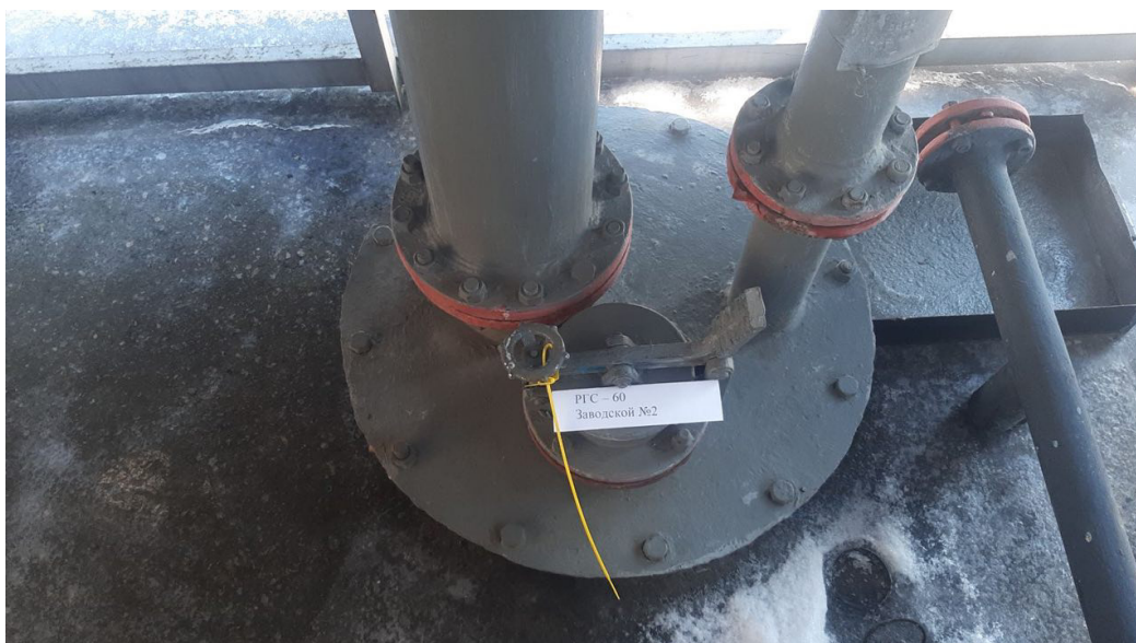
Рисунок 2 – Общий вид резервуара РГС-60 № 2
