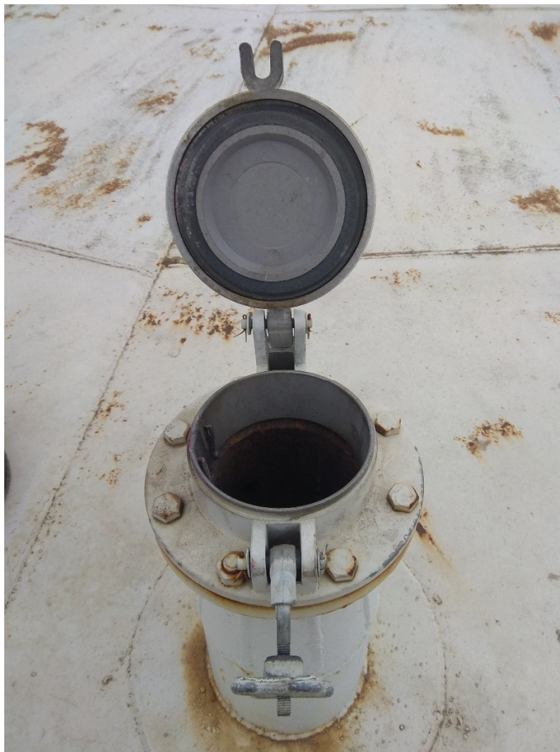
Рисунок 2 – Фотография крышки замерного люка резервуара вертикального стального цилиндрического РВС-2000 заводской номер 222
