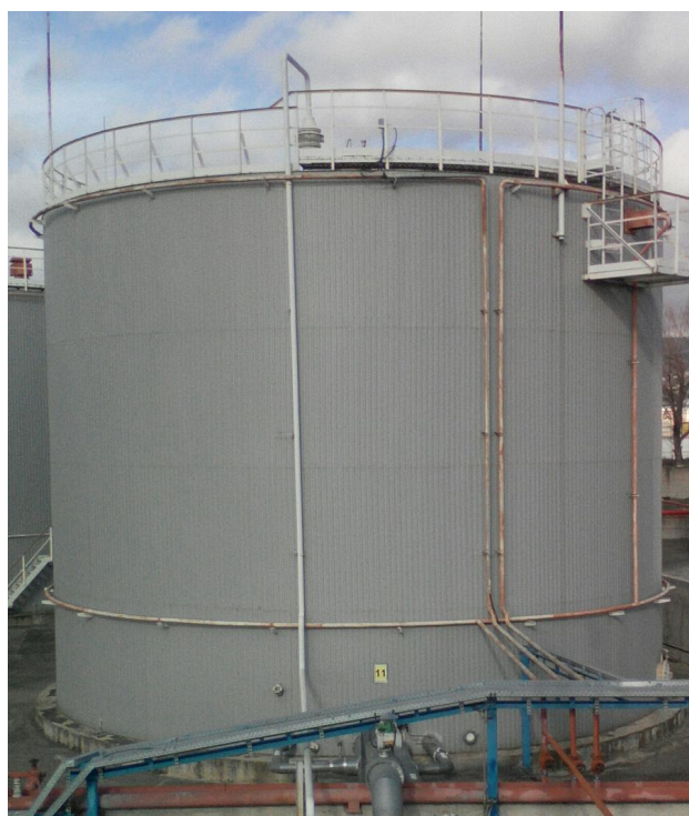
Рисунок 2 - Общий вид резервуаров вертикальных стальных РВС-2000 зав. №№ 9, 10, 11
