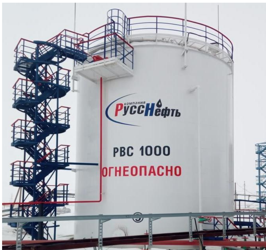
Рисунок 1 - Резервуар вертикальный стальной РВС-1000
