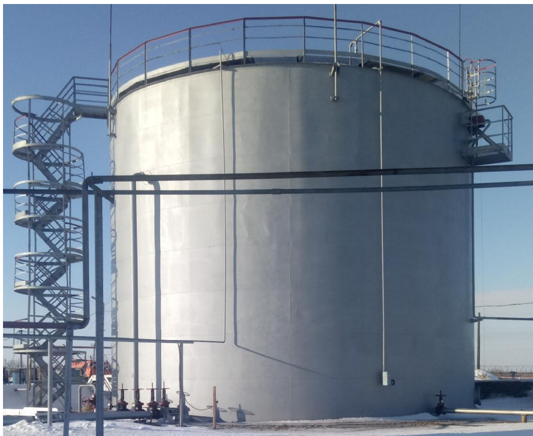
Рисунок 2 - Резервуар вертикальный стальной РВС-2000
