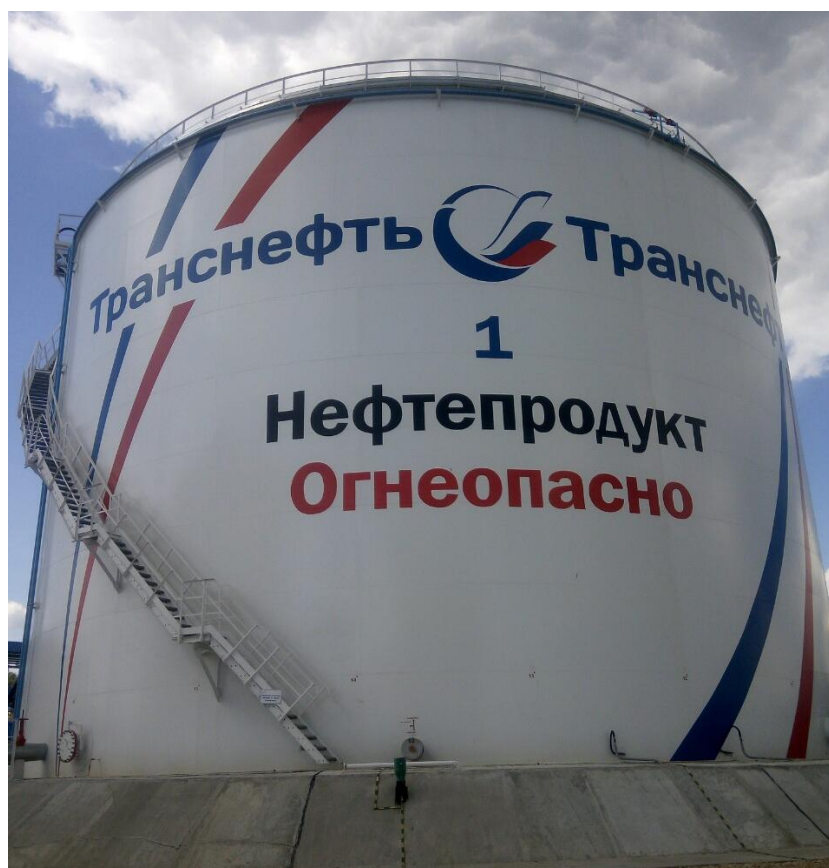
Рисунок 1 - Общий вид резервуаров вертикальных стальных цилиндрических РВС-10000
