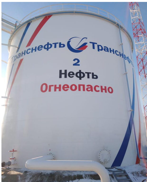
Рисунок 1 – Общий вид резервуара РВС-2000 зав.№2
