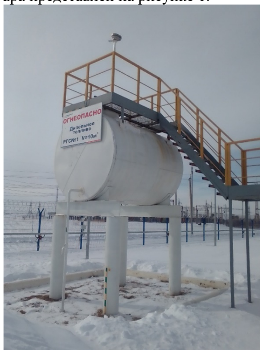
Рисунок 1 – Общий вид резервуара РГС-10
