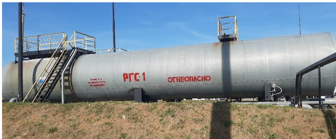
Рисунок 3 – Общий вид резервуара РГС-200 №37688
