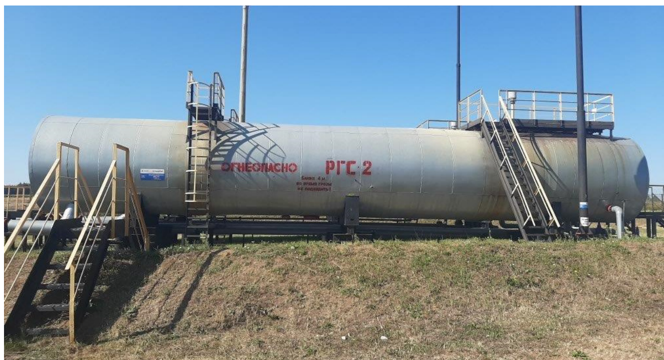
Рисунок 2 – Общий вид резервуара РГС-200 №37687
