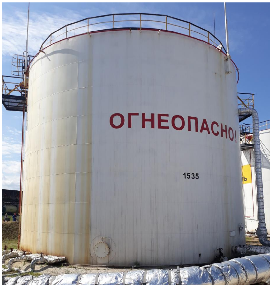
Рисунок 4 - Общий вид резервуара стального вертикального цилиндрического РВС-2000
