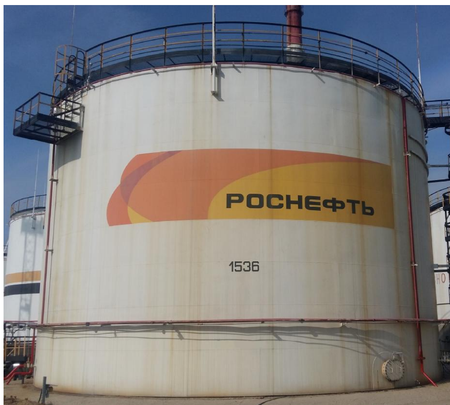
Рисунок 5 - Общий вид резервуара стального вертикального цилиндрического РВС-3000
