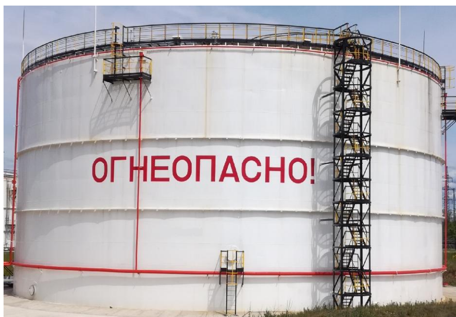
Рисунок 7 - Общий вид резервуара стального вертикального цилиндрического РВС-20000
