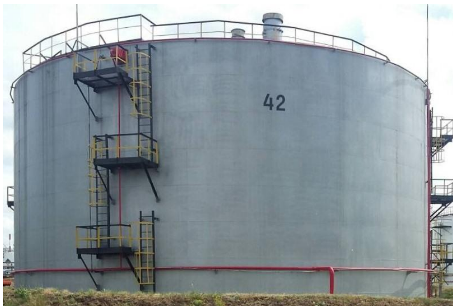
Рисунок 6 - Общий вид резервуара стального вертикального цилиндрического РВС-5000, РВСП-5000
