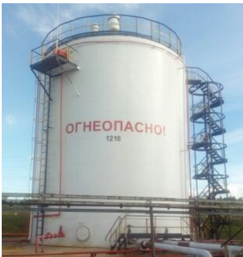
Рисунок 3 - Общий вид резервуара стального вертикального цилиндрического РВС-1000
