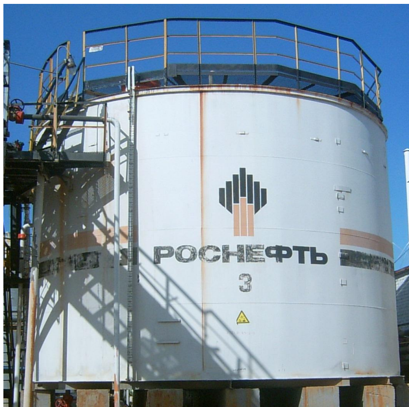
Рисунок 2 - Общий вид резервуара стального вертикального цилиндрического РВС-400
