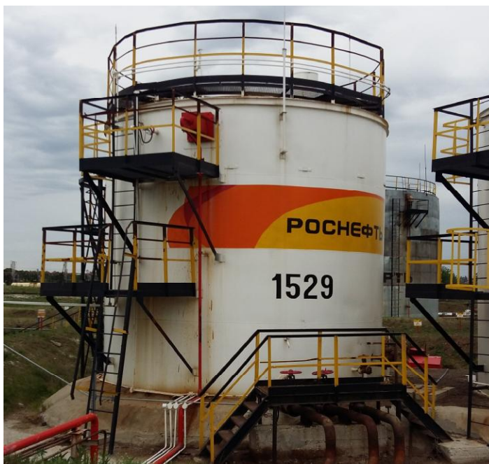
Рисунок 1 - Общий вид резервуара стального вертикального цилиндрического РВС-200
