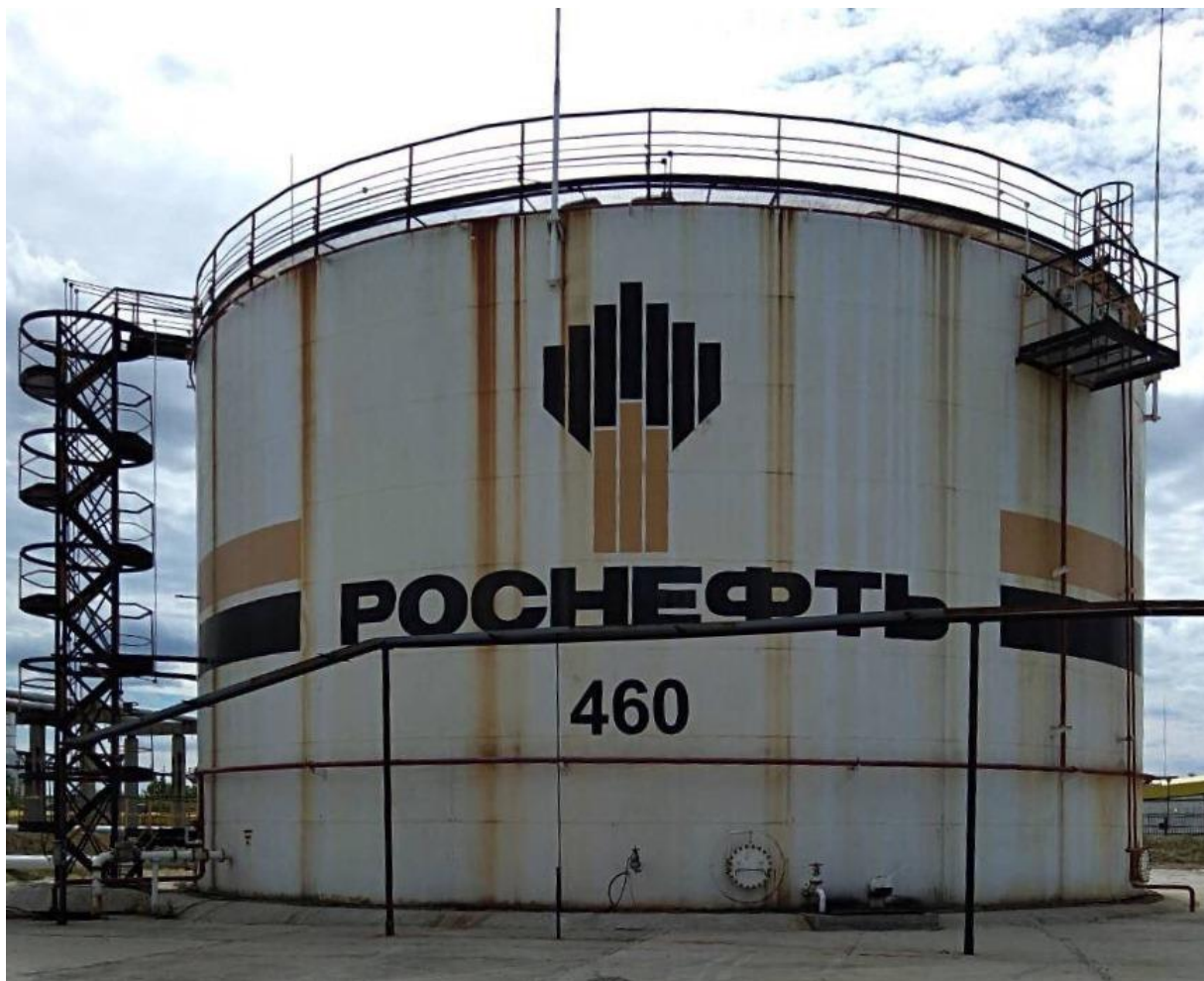
Рисунок 1 - Общий вид резервуара стального вертикального цилиндрического РВС-5000
