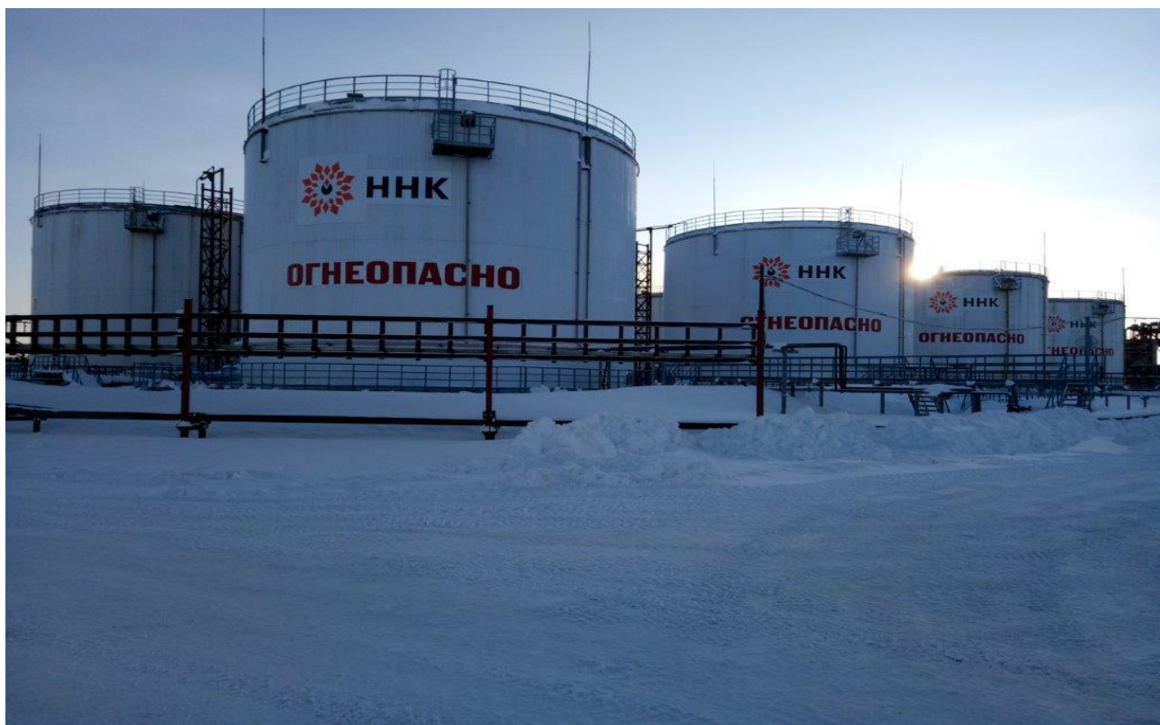
Рисунок 1 - Общий вид резервуаров РВС-5000
