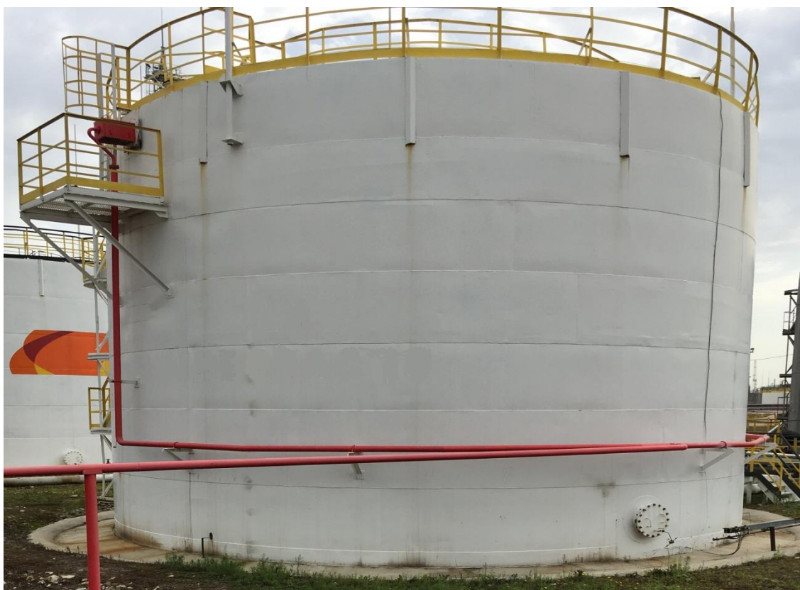
Рисунок 1 - Общий вид резервуара стального вертикального цилиндрического РВС-1000
