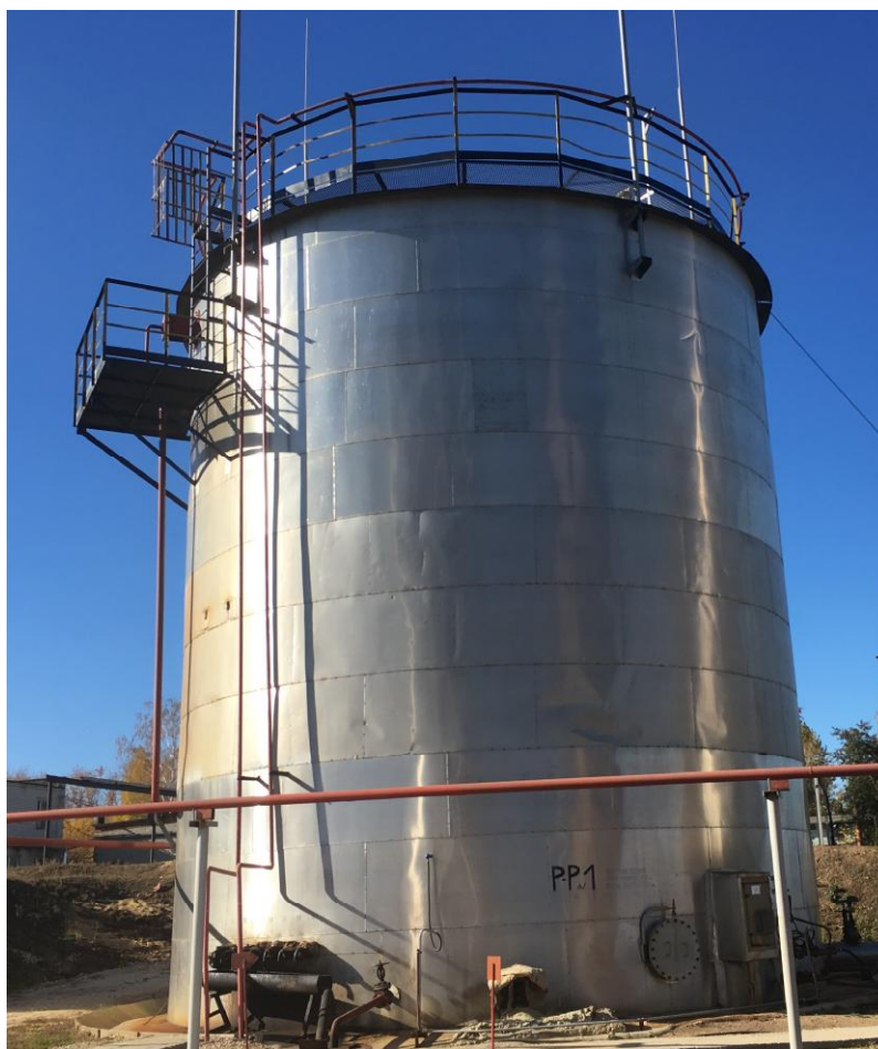
Рисунок 1 - Общий вид резервуара стального вертикального цилиндрического РВС-1000
