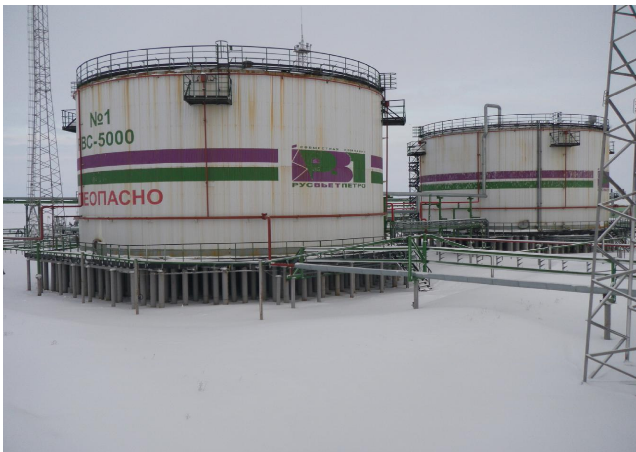
Рисунок 1 - Общий вид резервуаров РВС-5000
